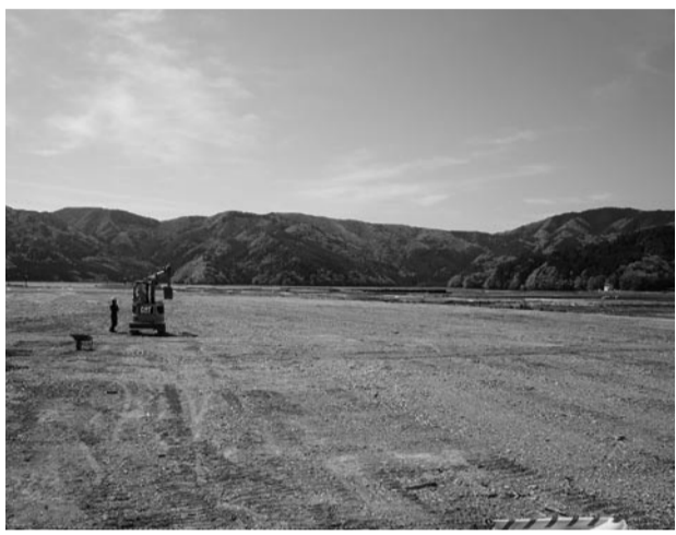
瓦礫が撤去され整地された海岸
